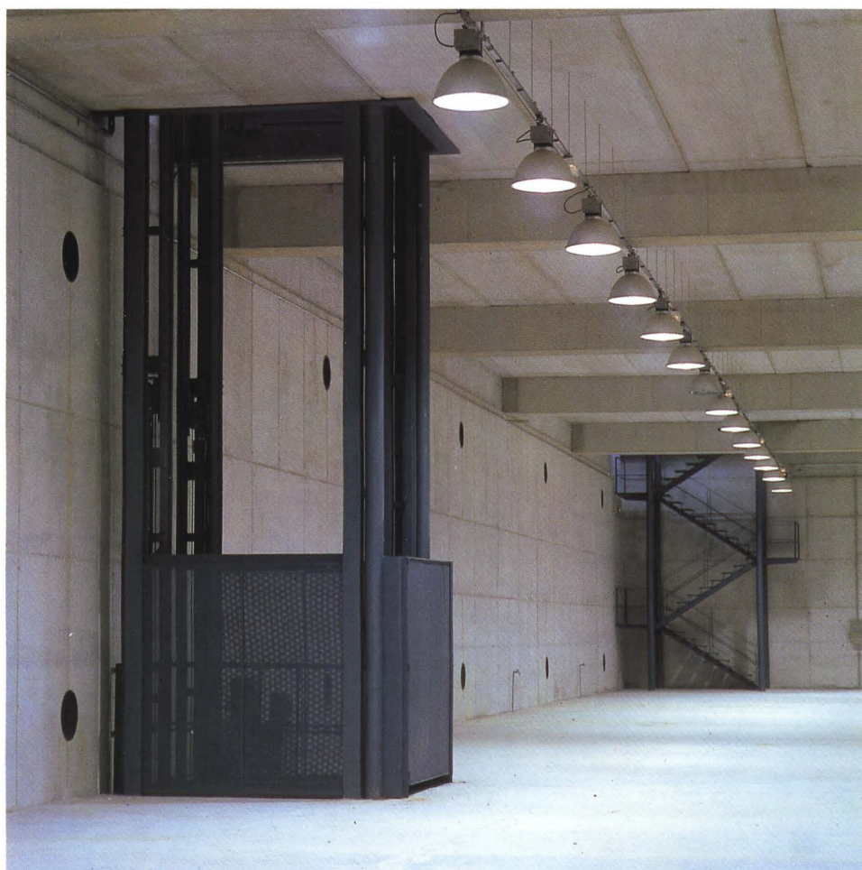
Vista interior del sótano. Interior view of lower level.
